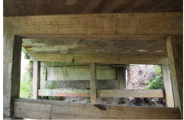
Figura 9. Estado actual de la Pila 1 del puente quebrada El Fierro donde se muestra la viga de amarre en estudio. Fuente: SAEP, 2016.
