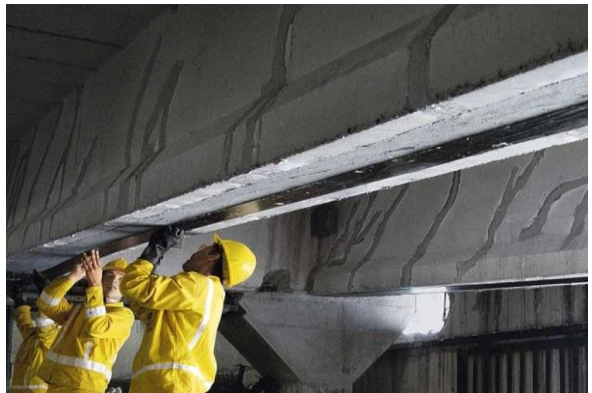
Figura 11. Colocado de FRP longitudinal en la zona de tensión de elementos de concreto para reparaciones en flexión con FRP. Fuente: Reinforced polymer plate products, TecTonica Online, 2017.
