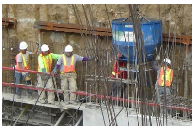
Imagen 1. Momento de colado (2 trabajadores colan, 3 esperan).
