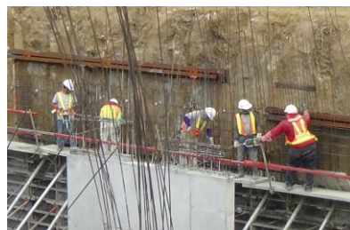
Imagen 2. Momento de vibrado (4 trabajadores vibran, 1 espera).
