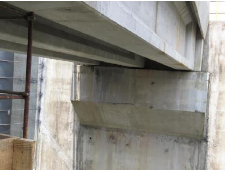
Figura 22. Fotografía de la superestructura.
