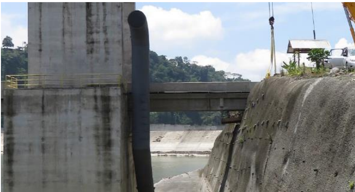
Figura 23. Fotografía lateral de la estructura.
