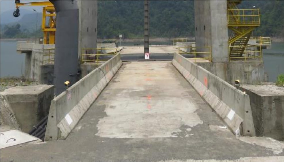
Figura 21. Fotografía en línea de centro de la estructura.
