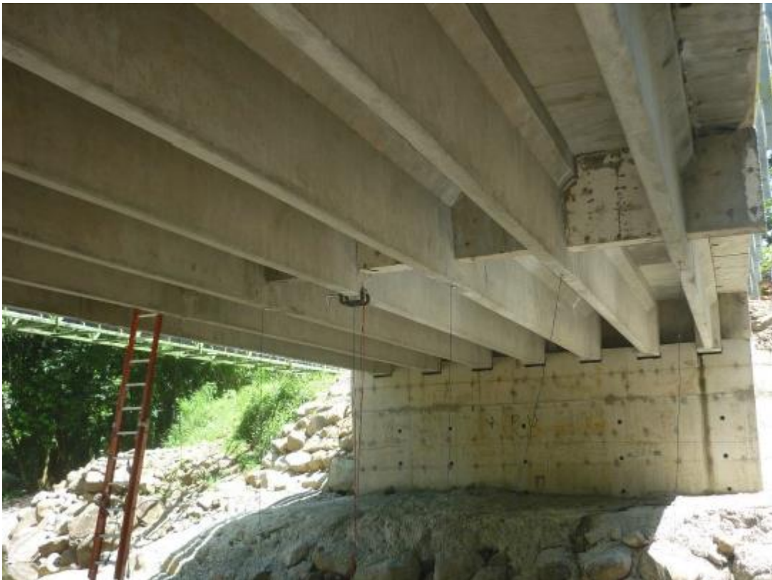
Figura 5. Fotografía de superestructura del puente sobre el Río Peje.
