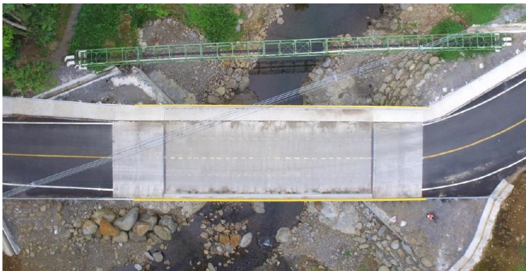
Figura 3. Vista aérea del puente sobre el Río Peje.
