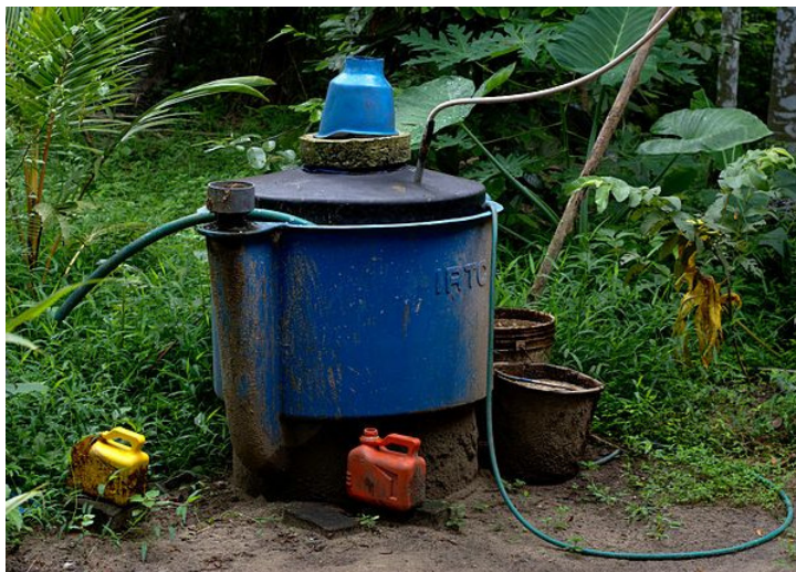
Figura 2: Un sistema de biodigestión para uso residencial. Fuente: Imagen de Kevinsooryan distribuido bajo la licencia CC BY-SA 4.0.
