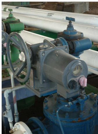
Figura A.8 Moto Válvula.
